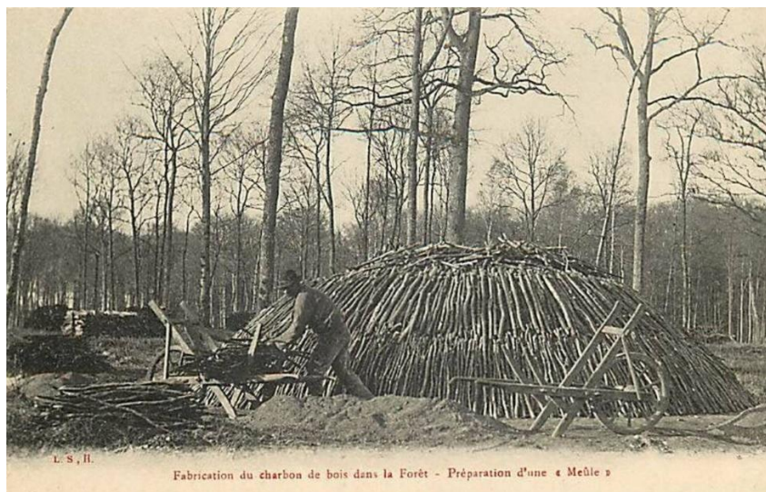
- Charbonnière avant sa couverture en terre -
