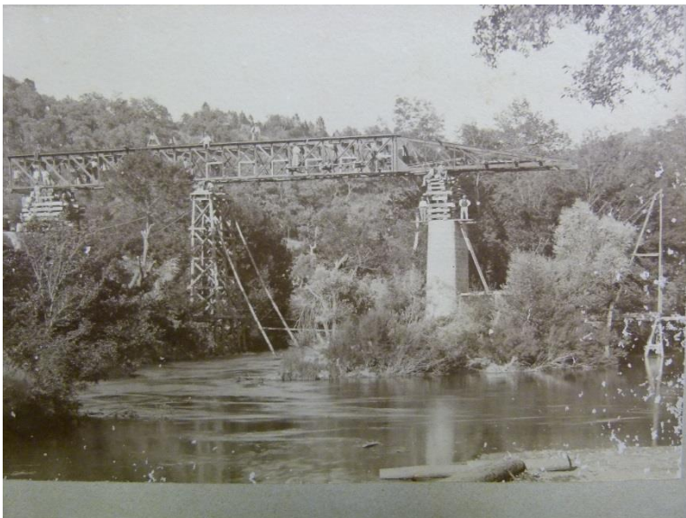
La construction du pont de l'Aille, dit « pont de fer » ou « pont Eiffel »
